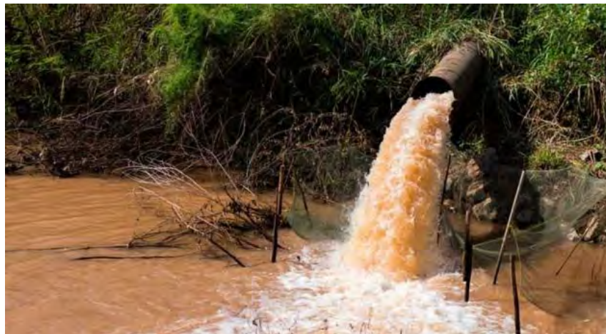
Figura 2. Ejemplo del vertido de aguas residuales sin un tratamiento. Adaptada de iagua UNAM (2018)
